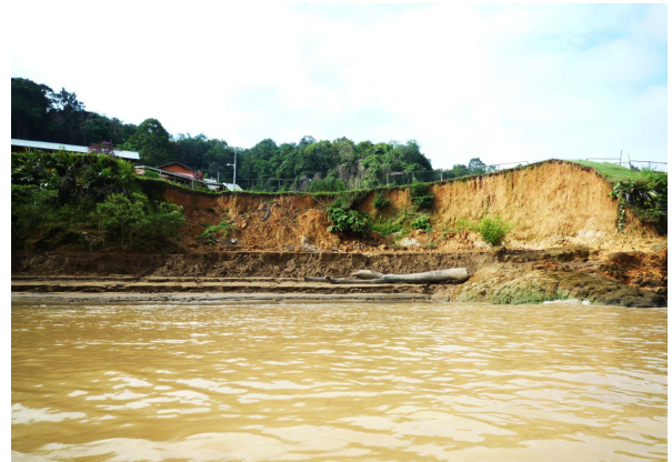
写真1 ラジャン川での特徴的な河岸侵食 小学校の校庭がえぐられ、サッカー等の球技はできない状況になっている。このような学校は流域に複数存在する。
