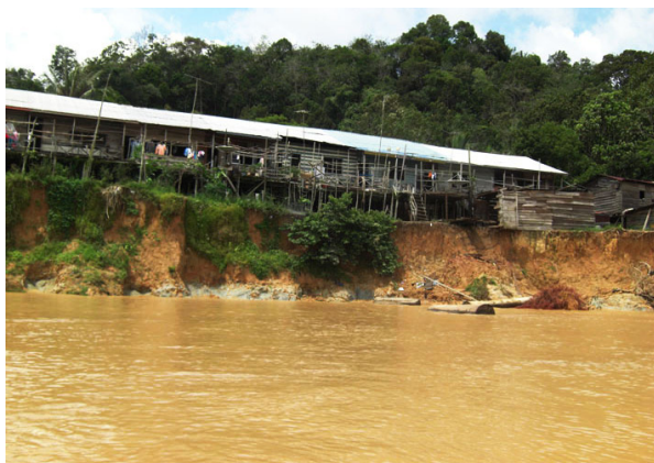
写真6 崩落の危機にあるロングハウス
