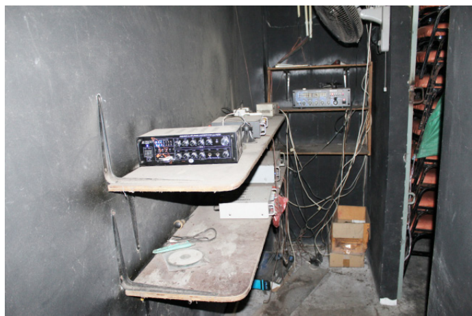
写真 8: ファーム・ハウス内部に設置された、アナツバメの鳴き声を録音した媒体を再生するための装置。(撮影: 市川 哲)
