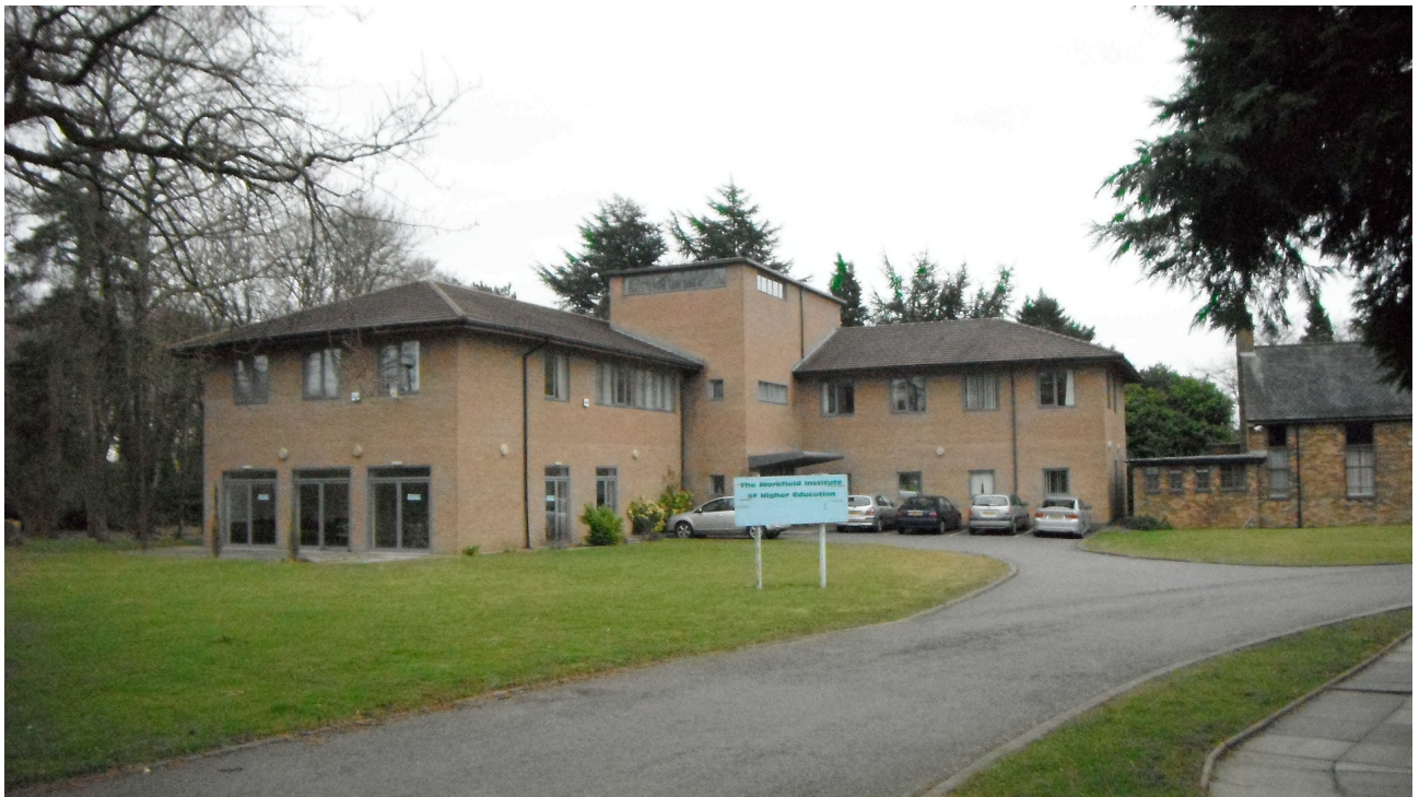
写真 2: マークフィールド高等教育研究所研究棟
