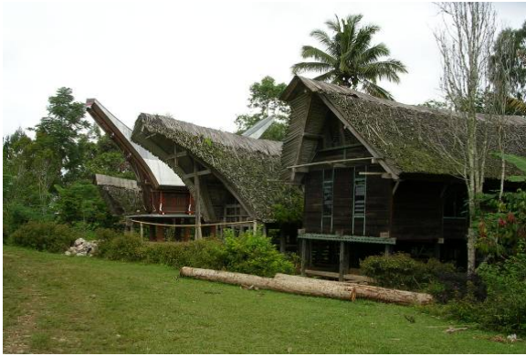
Gambar 2 Rumah Kediaman Penduduk dan lumbung yang berada di sisi kanan rumah tinggal. Keduanya tidak menghadap Utara-Selatan
