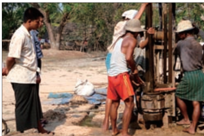
パテンでのボーリング Boring survey in Pathen
