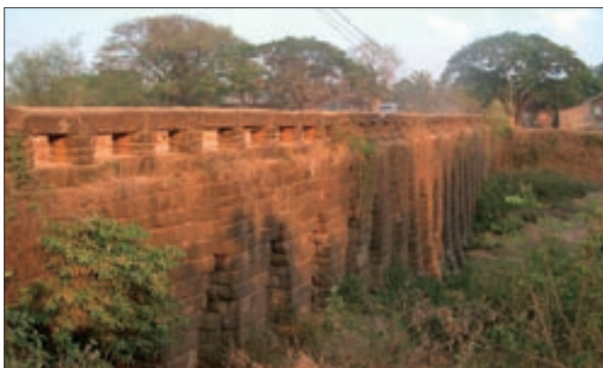
アンコールの古代橋（コンボン・クデイ橋） The ancient bridge of Angkor (Spean Kompong Kdei)
