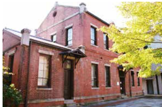
図書室本館は1870年代の旧京都織物会社赤煉瓦建築を転用している。
