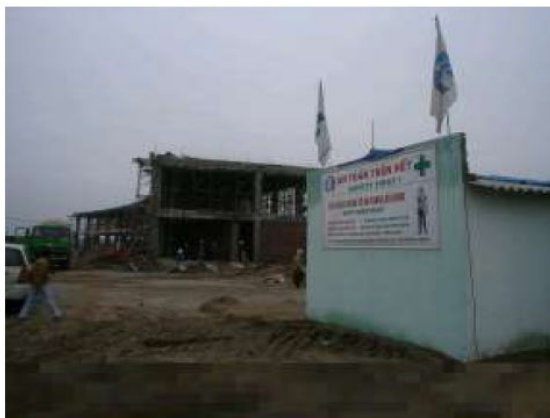
「日系工場の建設現場」
