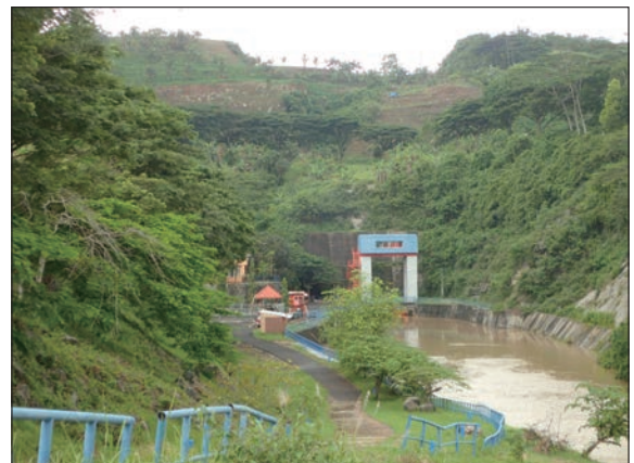
ネヤマトンネル 1961 年竣工 (戦後賠償) Neyamat Tunnel, 1961 (War Reparation)
