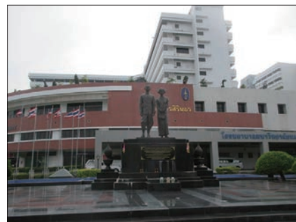
ナレースアン大学附属病院 Naresuan University Hospital
