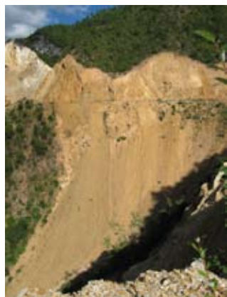
▲メコン川上流域における道路建設による斜面崩壊（中国・雲南省）
